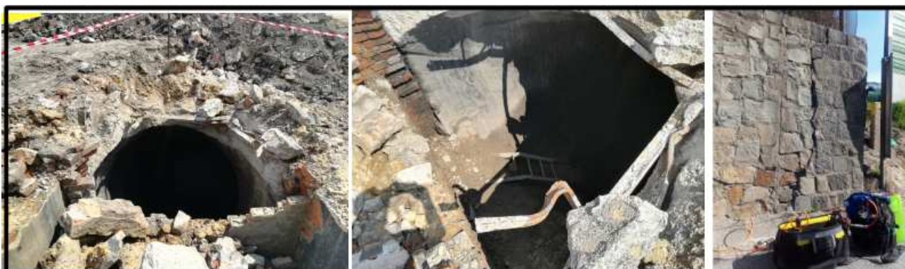
Fig. 5 Lokalizacja szybu oraz deformacja nieciągła
