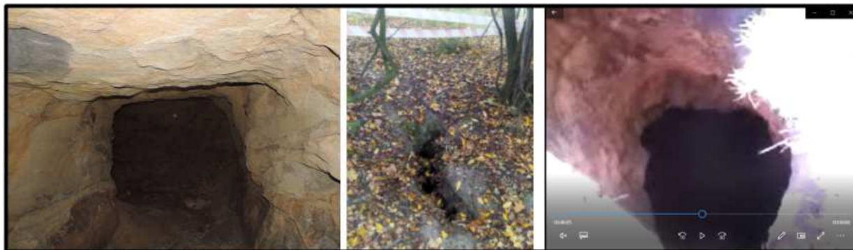
Fig. 4 Płytkie wyrobiska górnicze oraz deformacje nieciągłe
