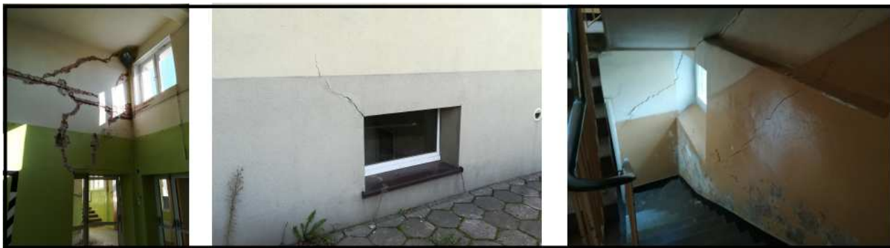
Fig.1 Skutki oddziaływania eksploatacji górniczej głębokiej na obiekty
